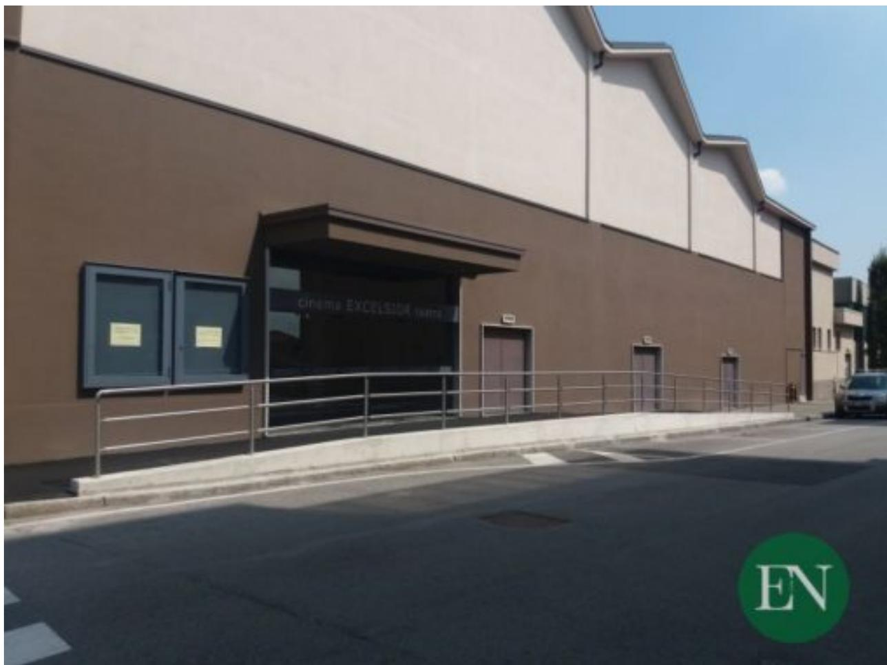
Sull'esterno, invece, con la nuova rampa è stato eliminato il dislivello tra le superfici, intervento necessario sia per l'abbattimento delle barriere architettoniche sia per questioni di sicurezza. Lo stesso accorgimento è stato tenuto sull'uscita di sicurezza che si affaccia sul cortile interno dell'oratorio Casa della Gioventù.
