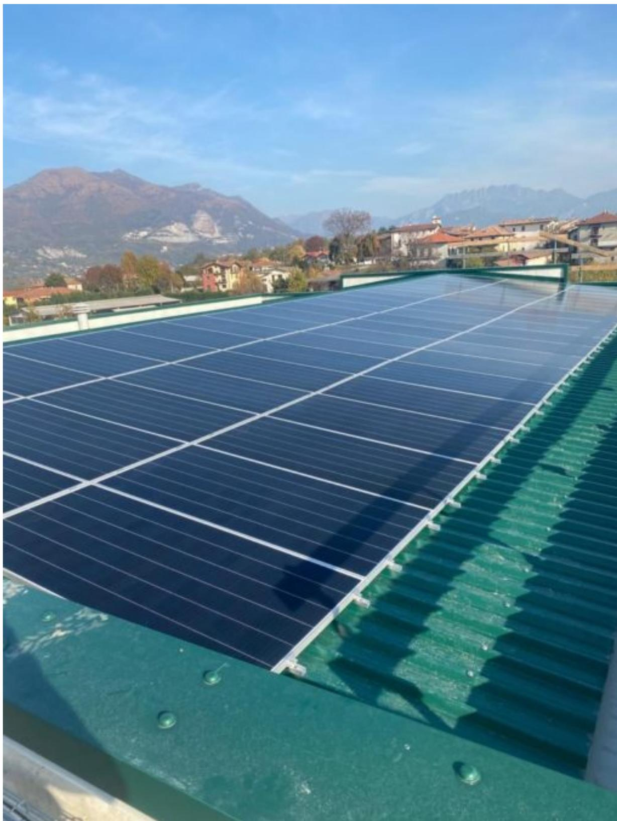
Con i lavori appena terminati dovrebbero essere scongiurate le infiltrazioni d'acqua che si erano verificate in passato e ora il comune è impegnato nella realizzazione di un **impianto fotovoltaico da 32 KWp**, con relativo sistema di accumulo, che consentirà una notevole riduzione dei consumi di energia elettrica.
