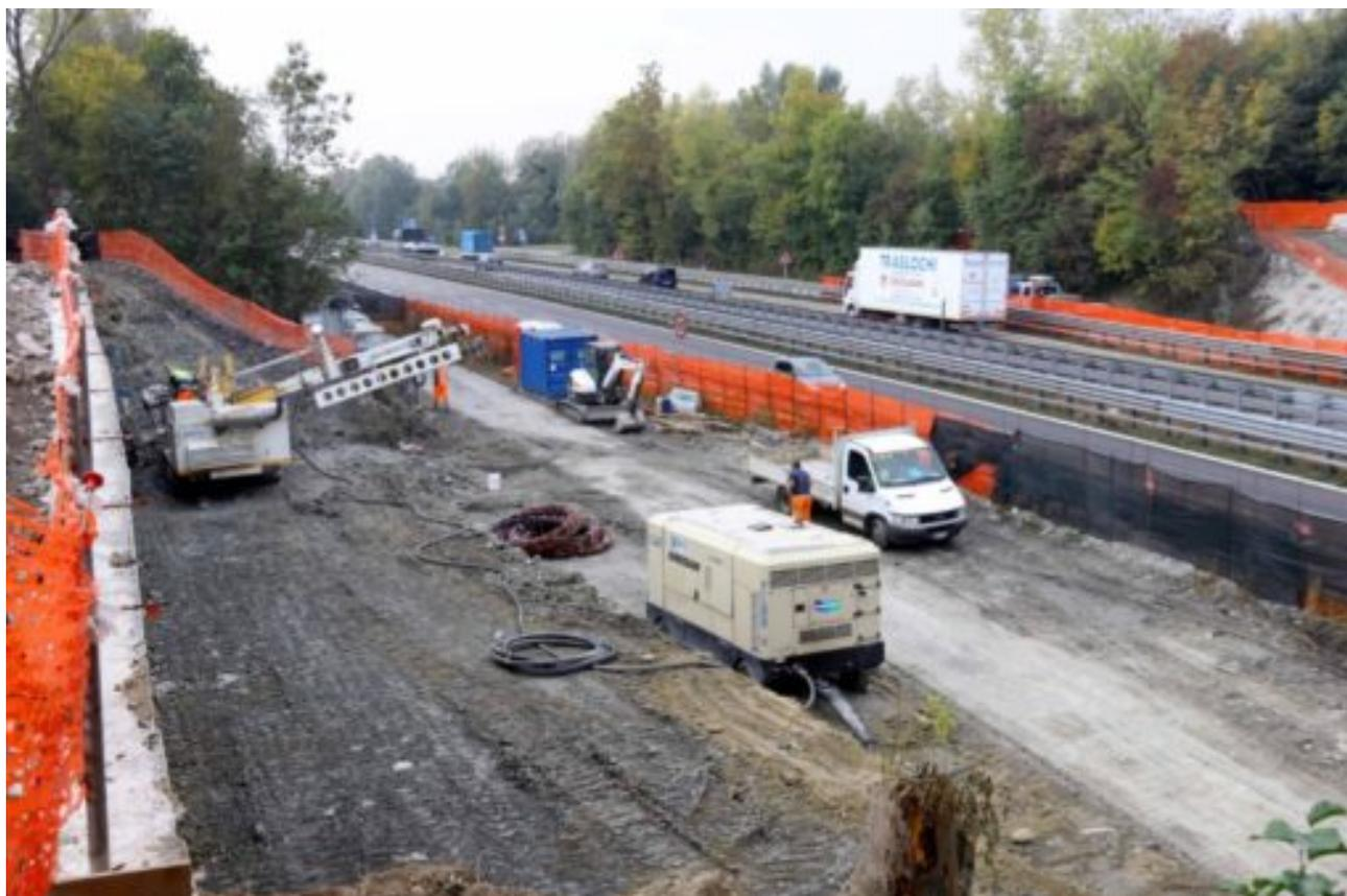
Gli operai stanno già predisponendo la zona dove l'impalcato sarà montato per poi essere trasferito attraverso carrelli in prossimità della Statale 36. Per il posizionamento dell'impalcato saranno utilizzate due potenti gru che solleveranno la struttura e la caleranno sulle spalle del ponte.
