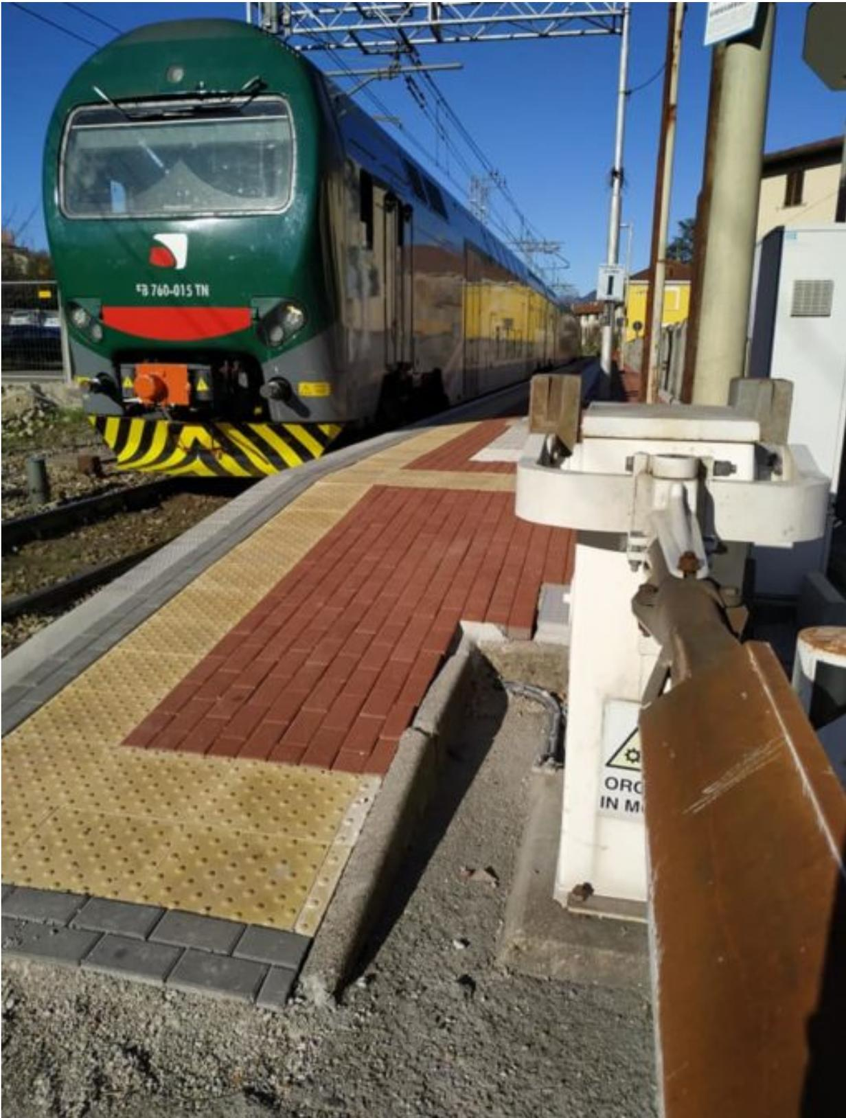
Le operazioni sono state **realizzate da Ferrovie Nord Milano in collaborazione con l’Ufficio Tecnico del Comune di Lambrugo**: le banchine sono state rinnovate e l’area di attesa è stata sistemata in modo che possa essere facilitato l’accesso ai vagoni per gli utenti diversamente abili, per gli anziani e per i genitori con bambini su passeggino.
