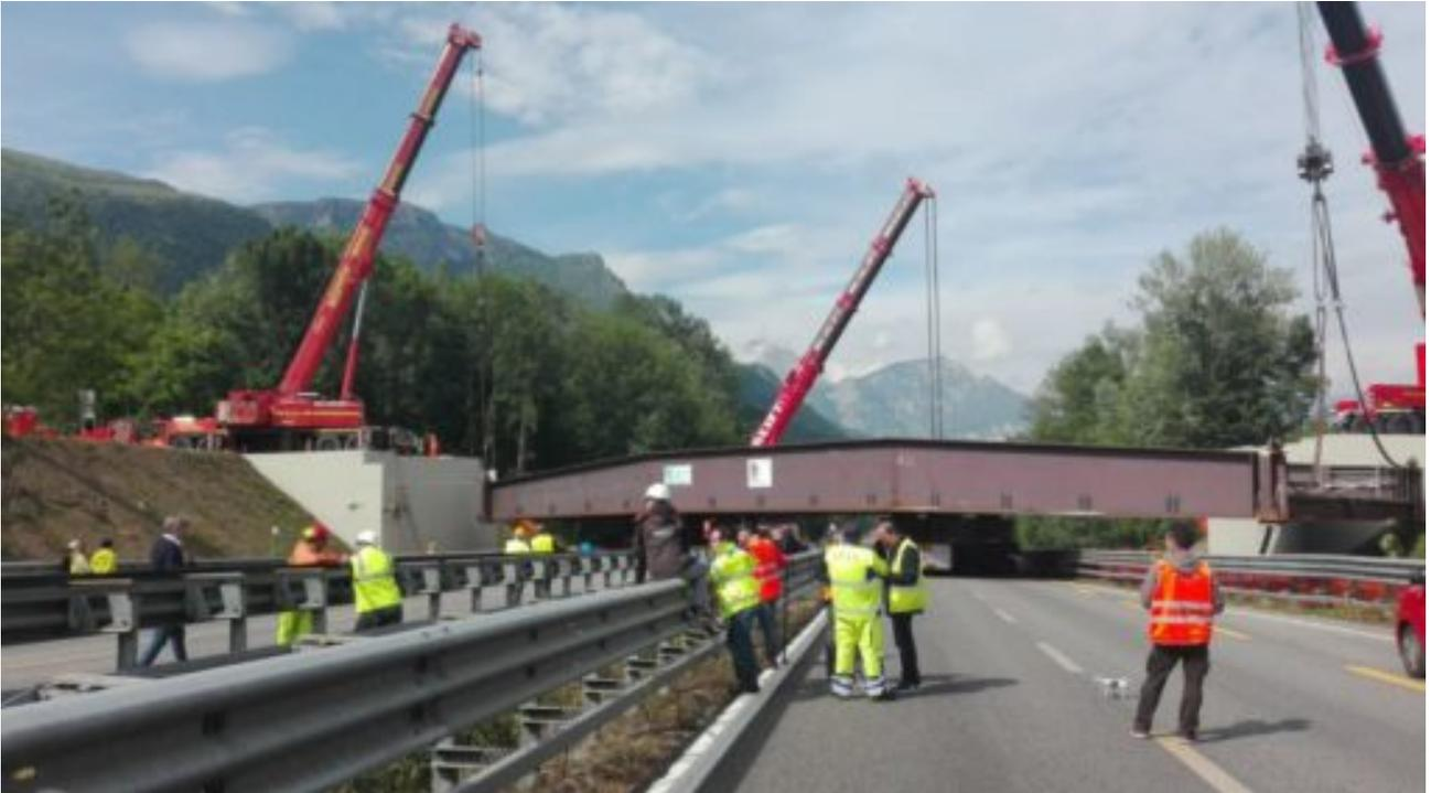
La struttura in acciaio corten, dal peso di 250 tonnellate, è stato allineata dopo lunghe manovre grazie ai bracci meccanici delle tre gru che da lunedì notte stanno lavorando sulla carreggiata della Statale 36, e quindi avvicinato alle spalle del ponte attraverso lo scorrimento dei carrelli posizionati al di sotto del manufatto.
