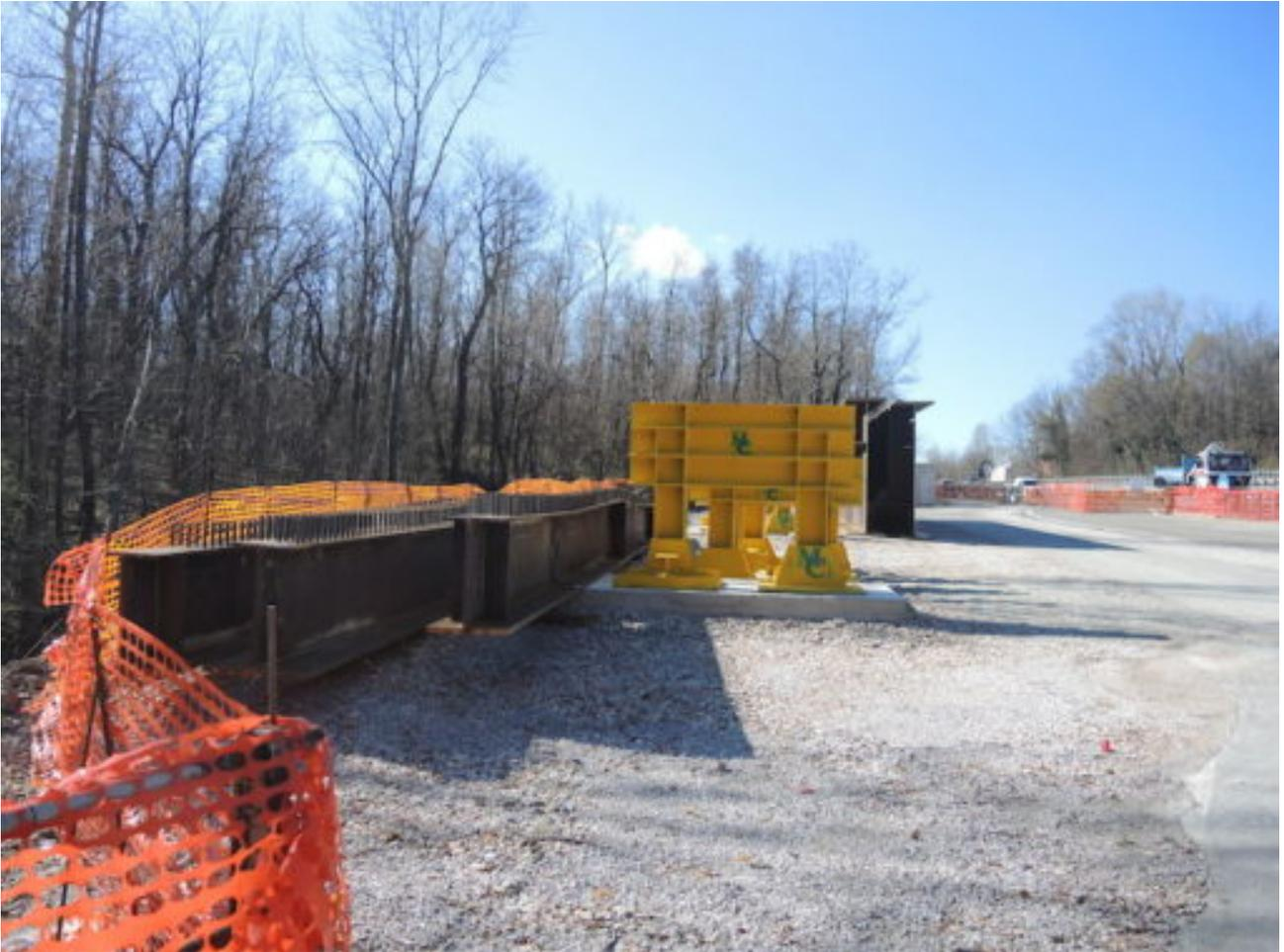
ANNONE - In più viaggi, fin dalla scorsa settimana, hanno fatto il loro arrivo ad Annone le **componenti metalliche del nuovo cavalcavia sulla Statale 36**: si tratta dei pezzi delle travi di ben 45 metri l'una che costituiranno l'impalcato del futuro ponte.
