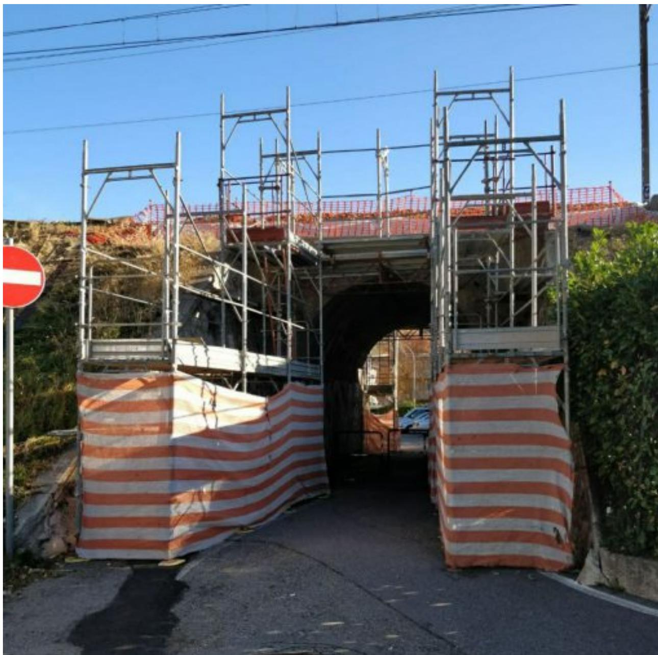
**PONTE LAMBRO - Sono iniziati quest'oggi, lunedì 20 novembre, i lavori da parte di FerrovieNord per la sostituzione dei parapetti e la formazione di camminamenti in prossimità del passaggio di via Piave.**
